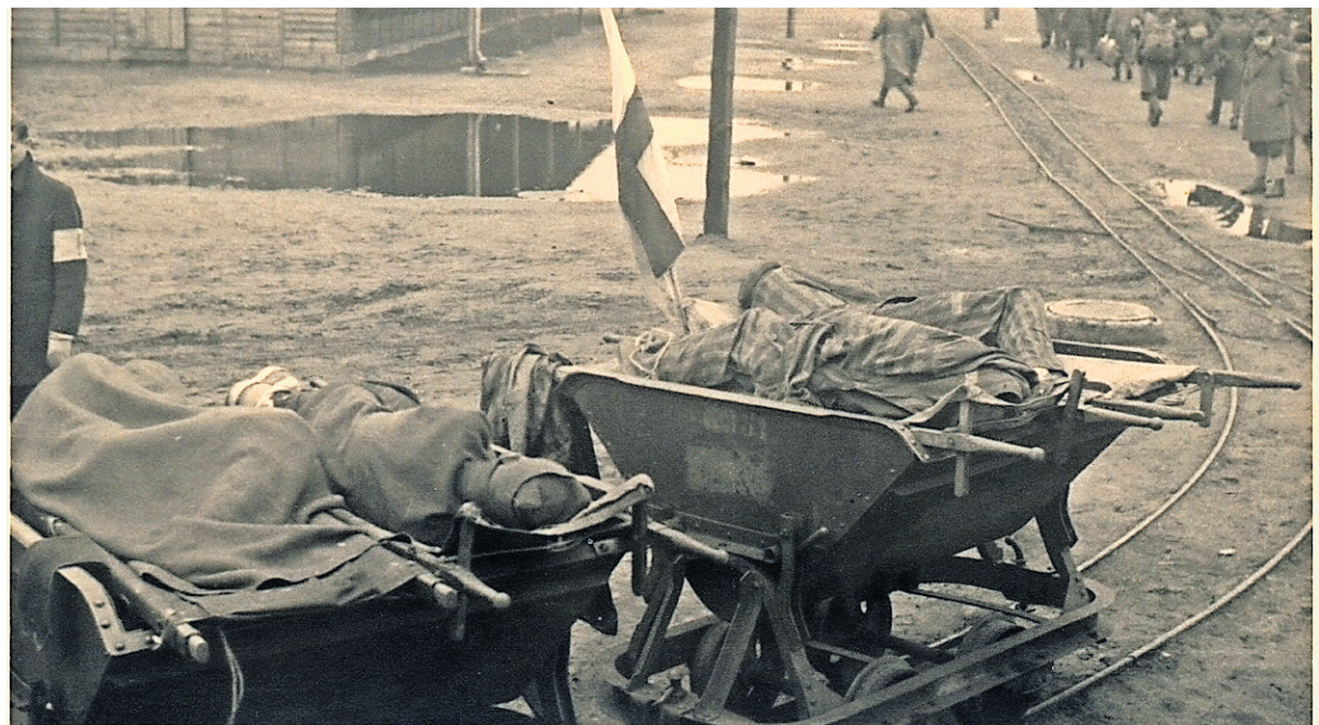
Nach der Übergabe des Lagers werden KZ-Häftlinge auf Loren zu Unterkünften gebracht, wo sie weiter versorgt werden.
